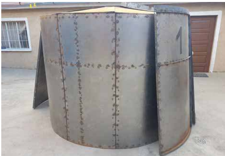
Foto 1. Molde circular desarmable interno y externo del tanque de ferrocemento.
