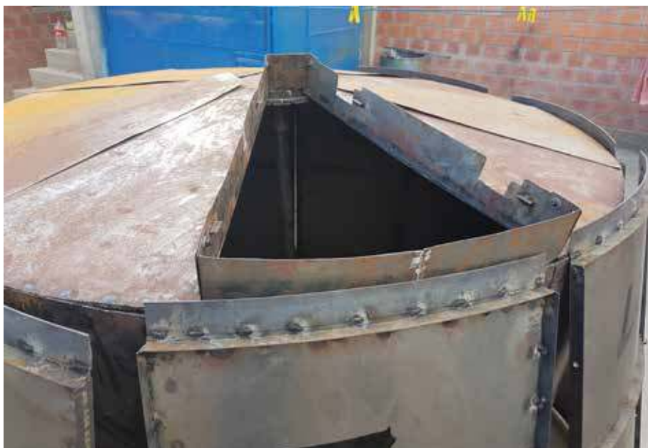
Foto 2. Molde circular desarmable y soporte de la tapa del tanque
